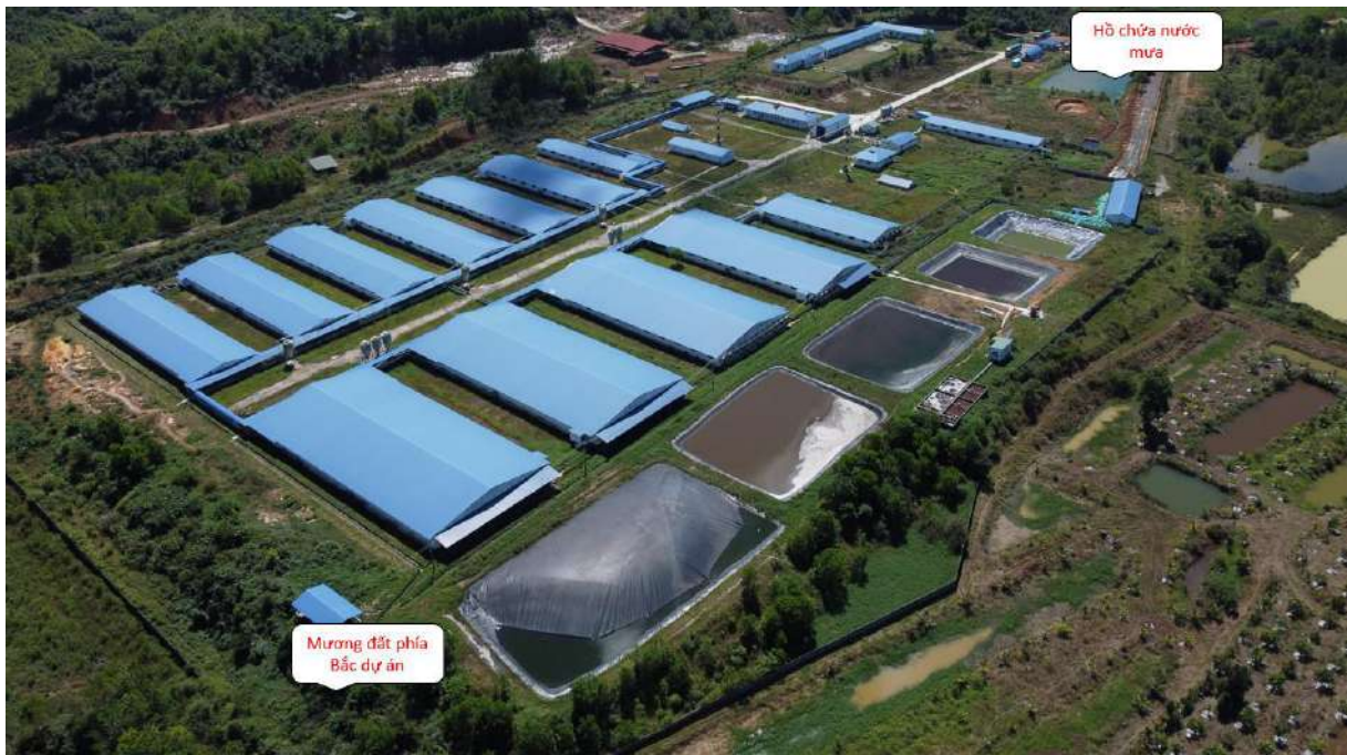
Hình 3.3: Hình ảnh hệ thống thu gom và thoát nước mưa của trang trại
