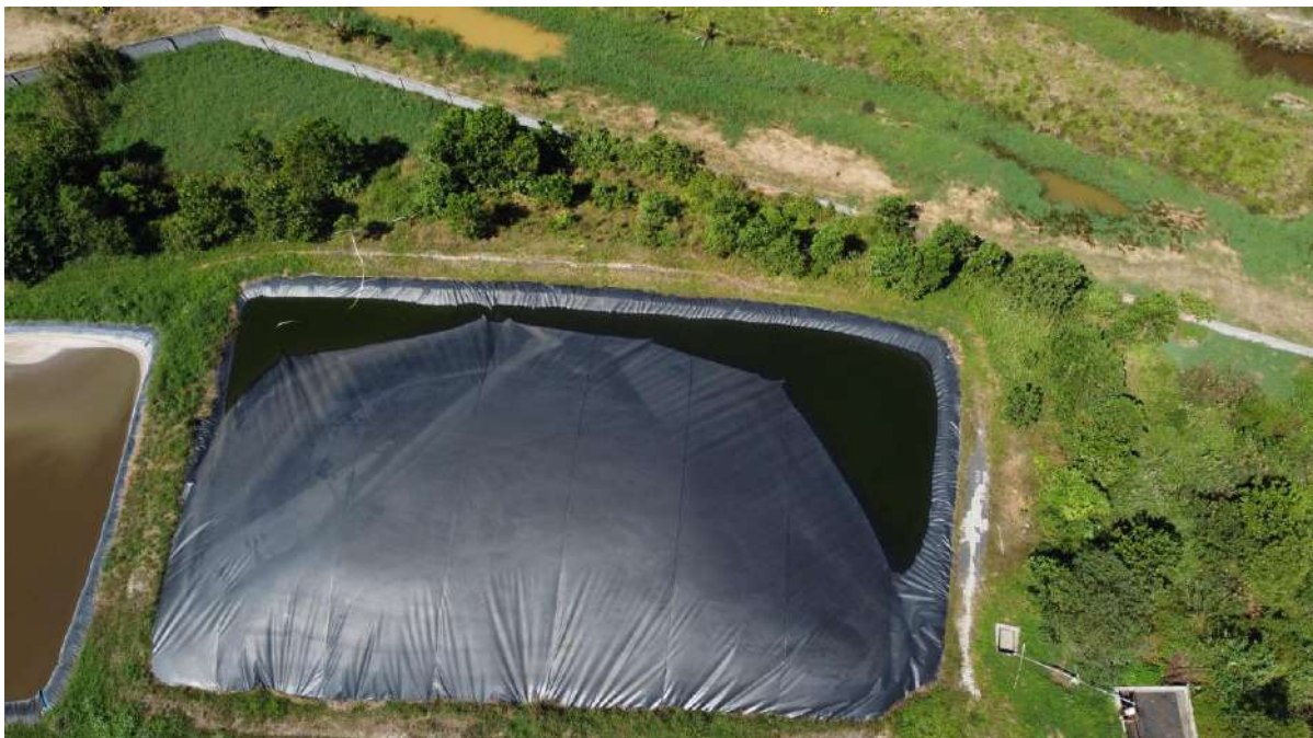
Hình 3.8: Hình ảnh hầm Biogas
