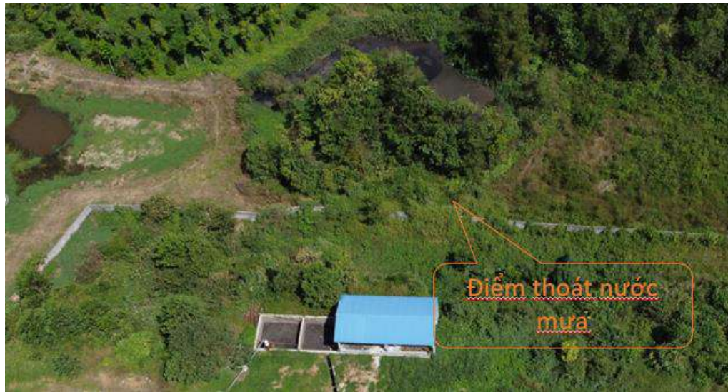
Hình 3.4: Hình ảnh mương thoát nước mưa của trang trại
