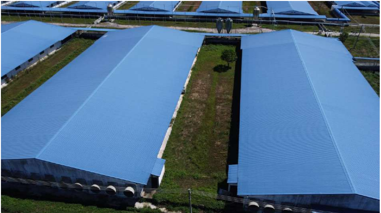
Hình 3.12: Hình ảnh hệ thống nhà lưới và phun chế phẩm khử mùi sau quạt hút
