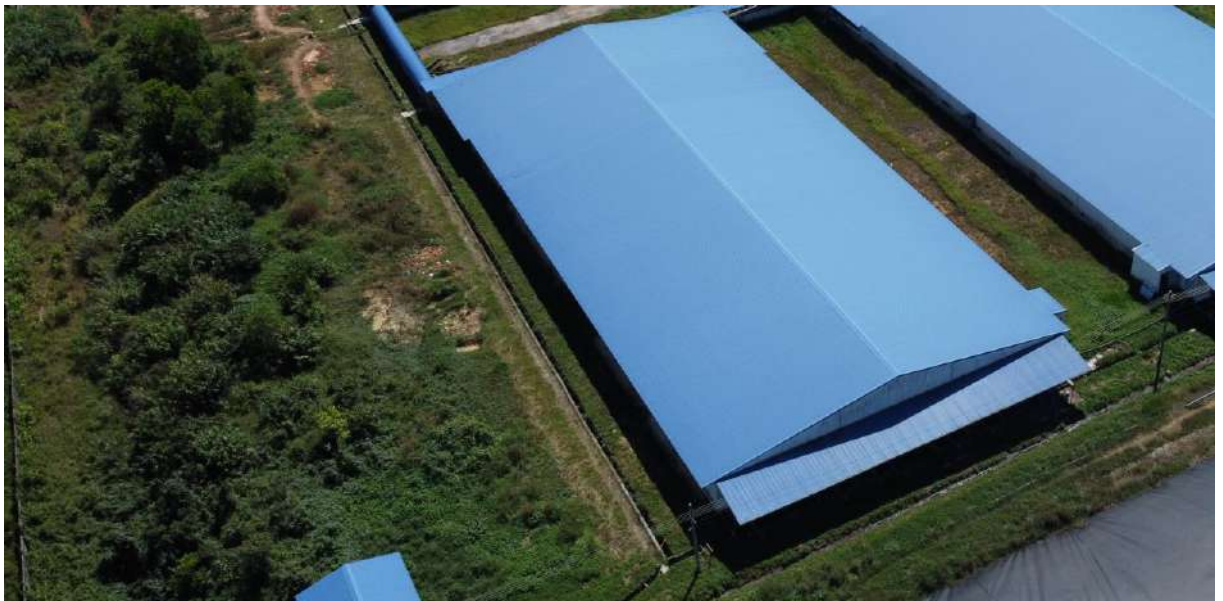
Hình 3.5: Hình ảnh mương thu gom nước thải hiện tại của trang trại
