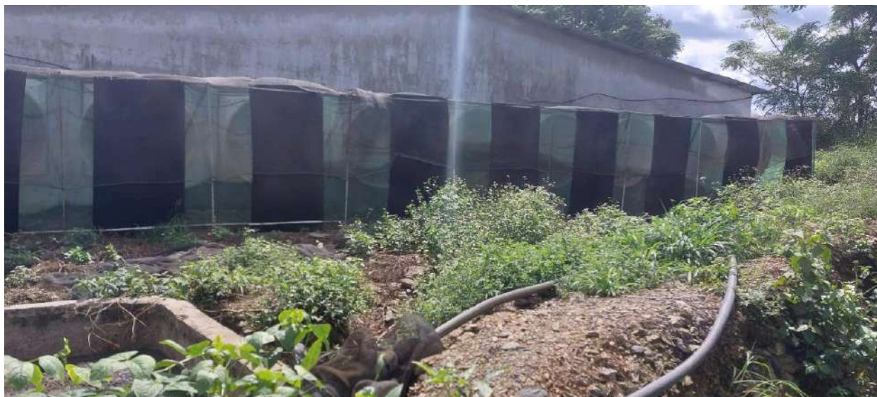
Hình 3.11. Khung lưới che chắn, khử mùi bằng than hoạt tính
