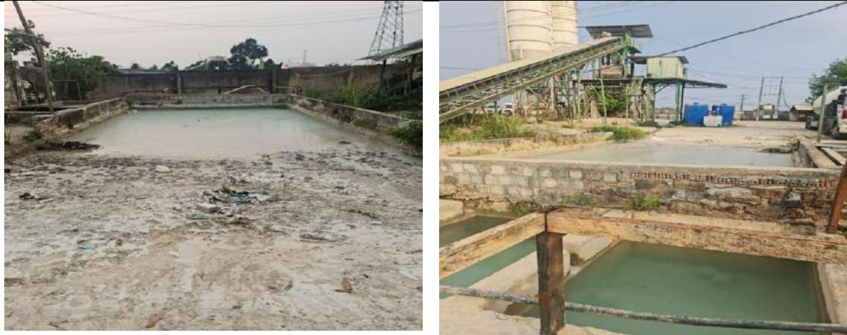
Hình 3-7: Hệ thống các bể lắng xử lý nước thải sản xuất của cơ sở
