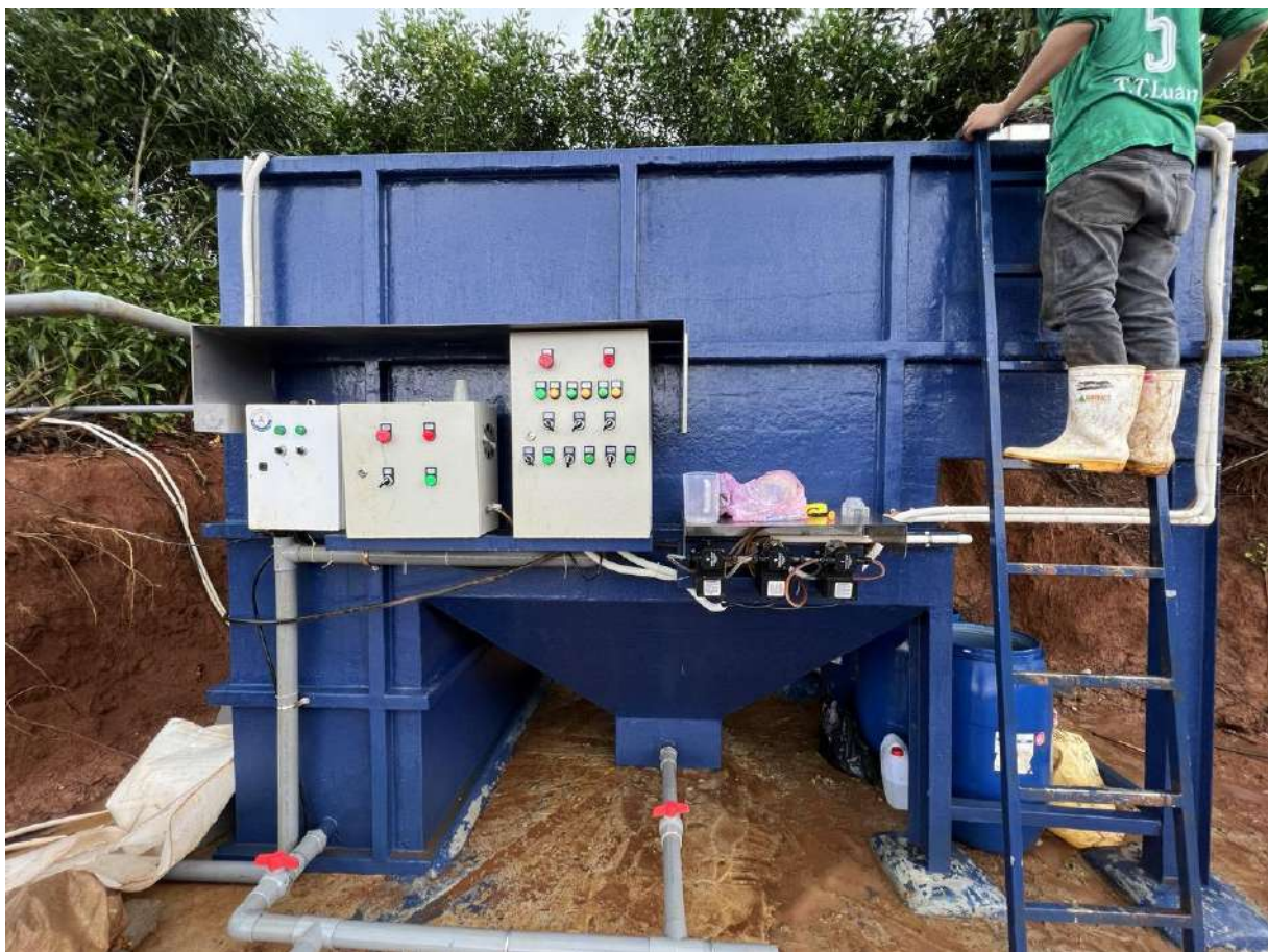
Hình 3.10: Hình ảnh Modul xử lý nước thải – công suất 50m 3 /ngày đêm của Trại Đồng Tiến 1 của Hộ gia đình ông Nguyễn Văn Trí tại xã Đăk Sin, huyện Đăk R'Lấp
