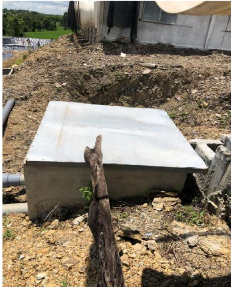
Hình 3.4: Hình hố ga thu gom nước thải
