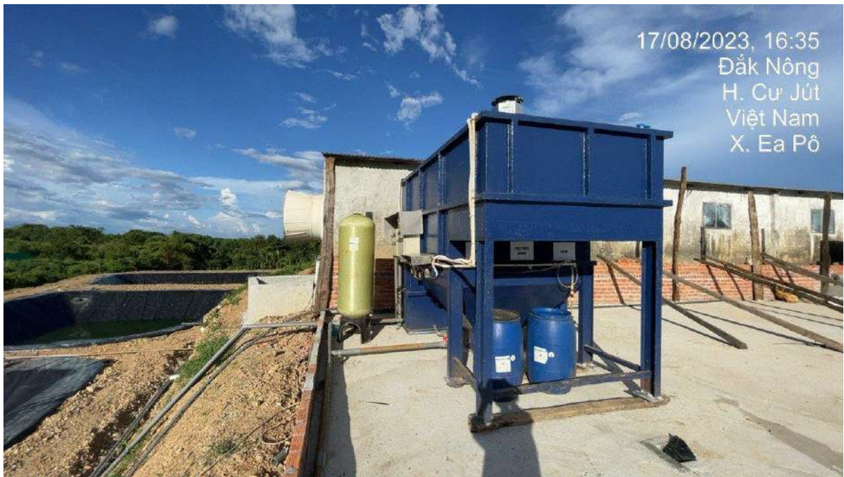
Hình 3.9: Hình ảnh Modul xử lý nước thải – công suất 50m 3 /ngày đêm của Trại chăn nuôi heo thịt Hộ gia đình ông Lương Hữu Tâm tại xã Ea Pô, huyện Cư Jút
