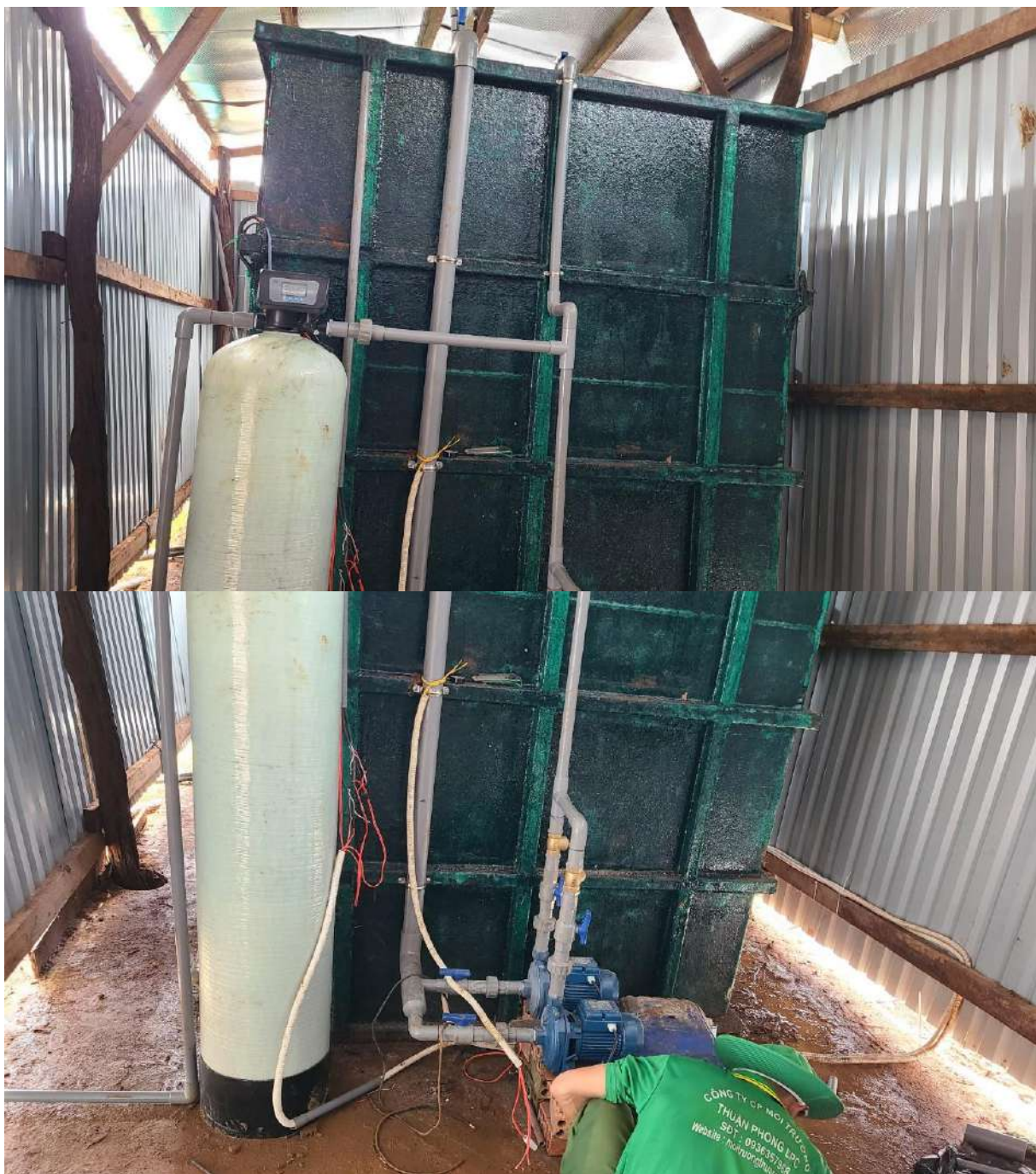
Hình 3.11: Hình ảnh Modun xử lý nước thải – công suất 50m 3 /ngày đêm của Trang trại chăn nuôi Hộ gia đình Phan Văn Quý tại xã Đắc Ru, huyện Đắc R'Lấp
