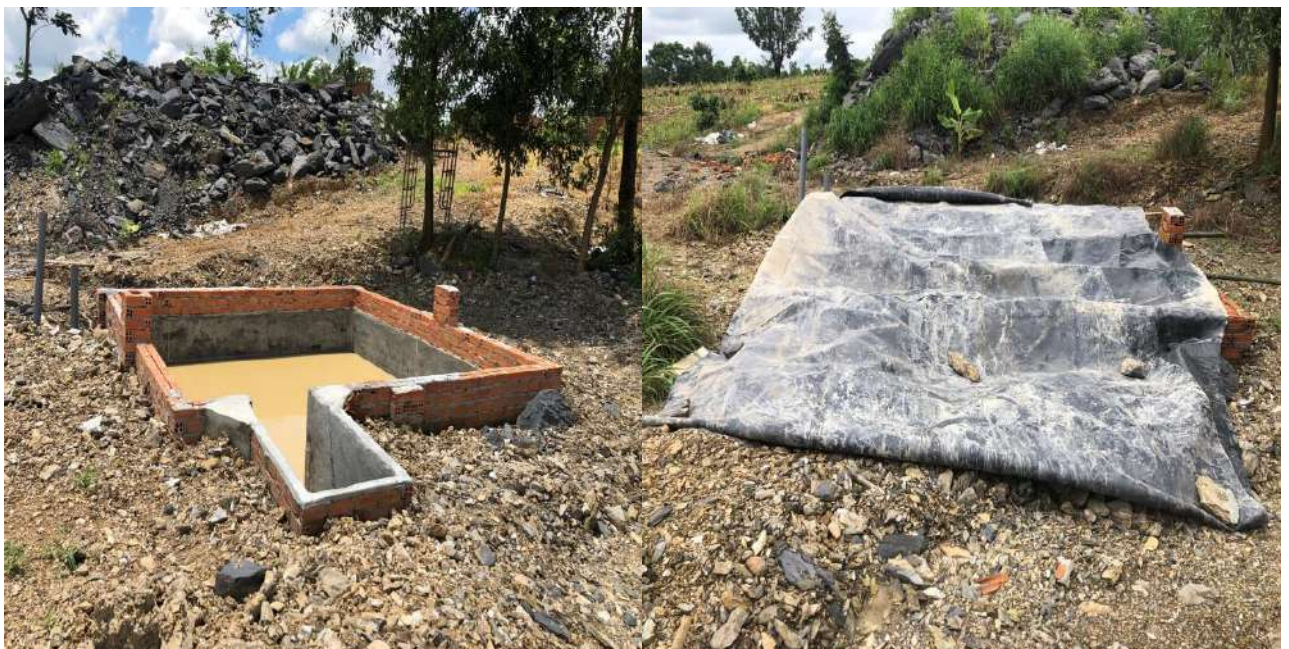
Hình 3.5: Hình hố tách phân
