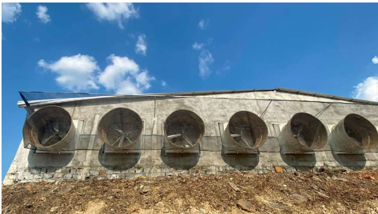
Hình 3.14: Hình ảnh minh họa khung lưới che chắn và hệ thống phun sương khử mùi sau quạt hút
