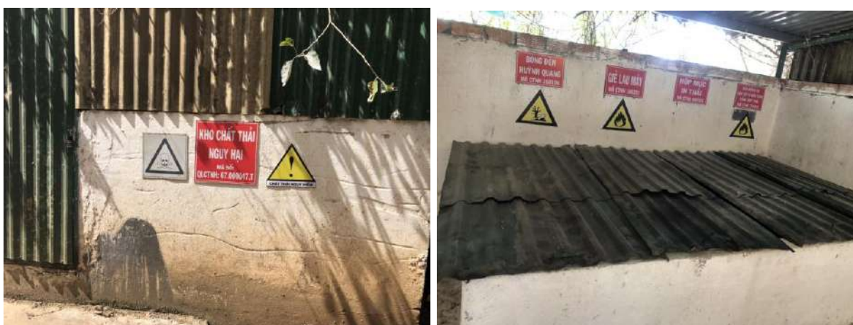
Hình 21. Nhà chứa chất thải nguy hại
