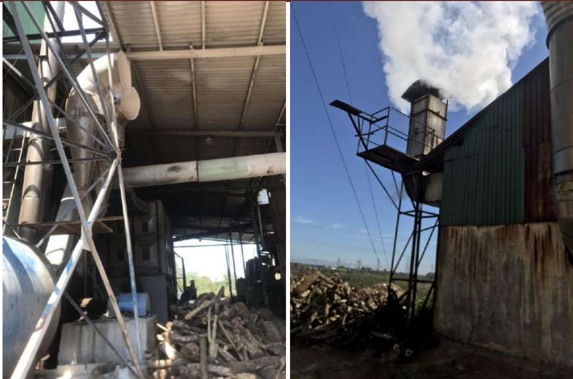
Hình 18. Cyclone và ống khói lò sấy
