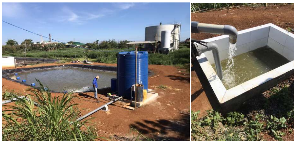
Hình 17. Cụm hóa lý và hồ bơm trước khi xả ra môi trường
