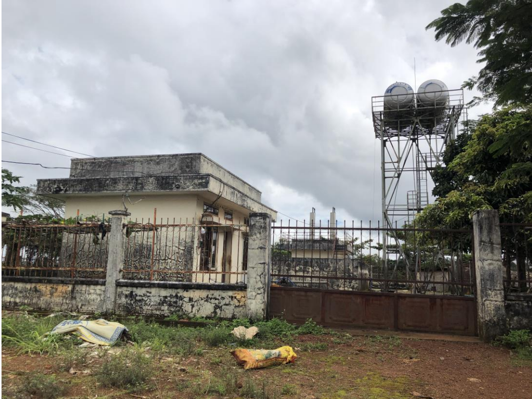
Hình 1.3. Trạm cấp nước đã được xây dựng trong Cụm công nghiệp
