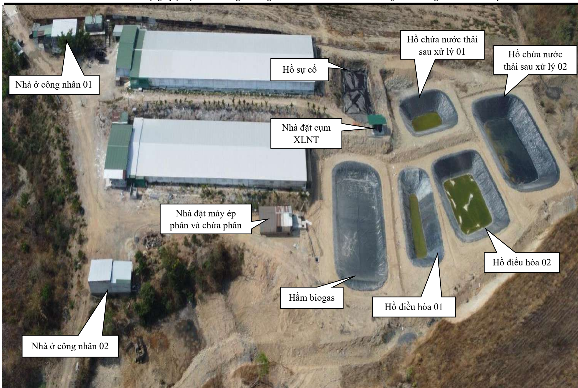
Hình 3.10: Hình ảnh hệ thống xử lý nước thải tập trung của trang trại
