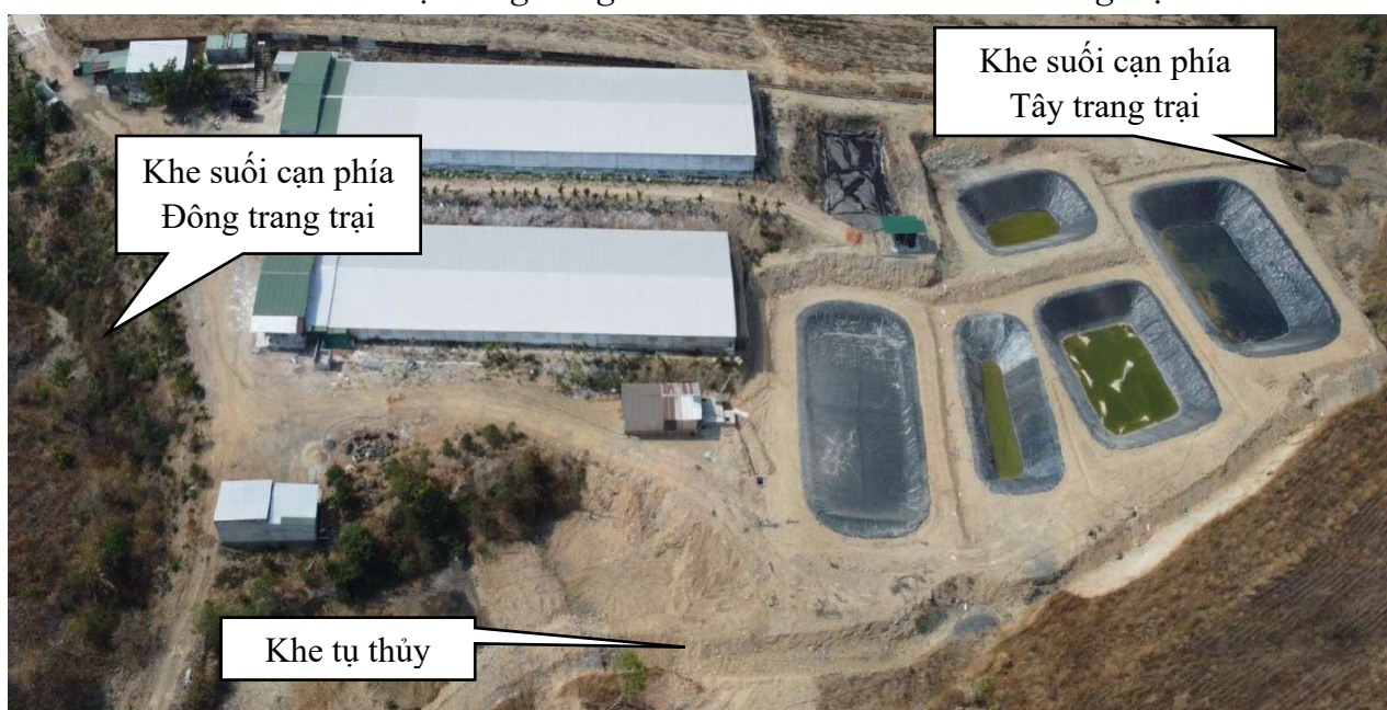
Hình 3.3: Hình ảnh hệ thống thu gom và thoát nước mưa của trang trại
