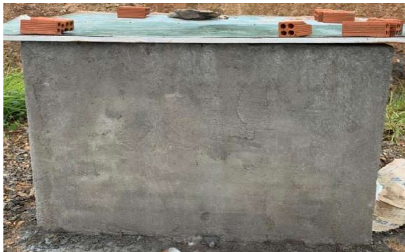
Hình 3.24: Hình ảnh Bể ủ xác heo của trang trại
