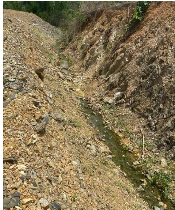
Hình 3.4: Hình ảnh mương đất và khe tụ thủy thoát nước mưa của trang trại
