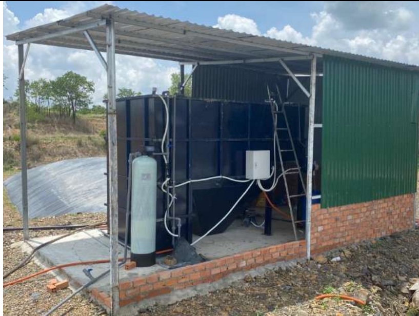
Hình 3.14: Hình ảnh Module XLNT hợp khối
