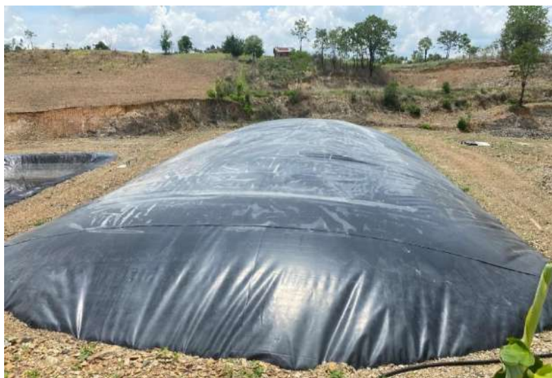
Hình 3.11: Hầm biogas
