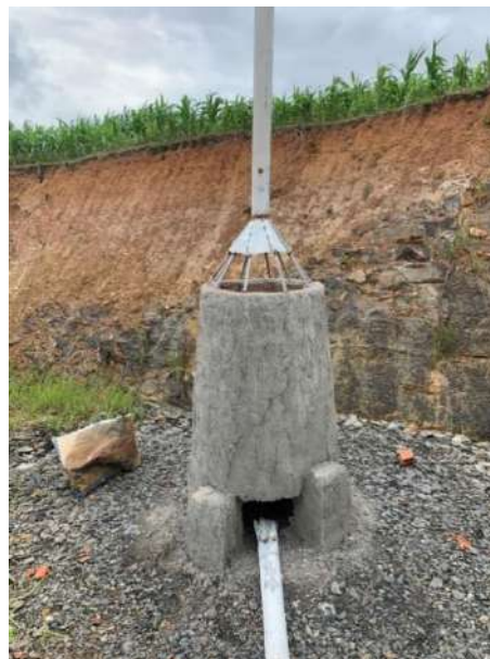
Hình 3.19: Hình khu vực đốt khí gas thừa
