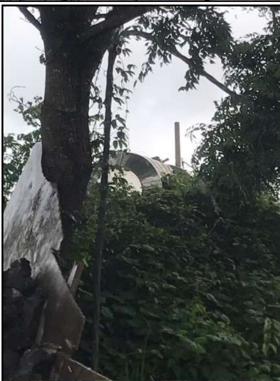
Hình 20. Bồn chứa nước dung tích 12 m 3 và 1 m 3 tưới giảm thiểu tại cơ sở
