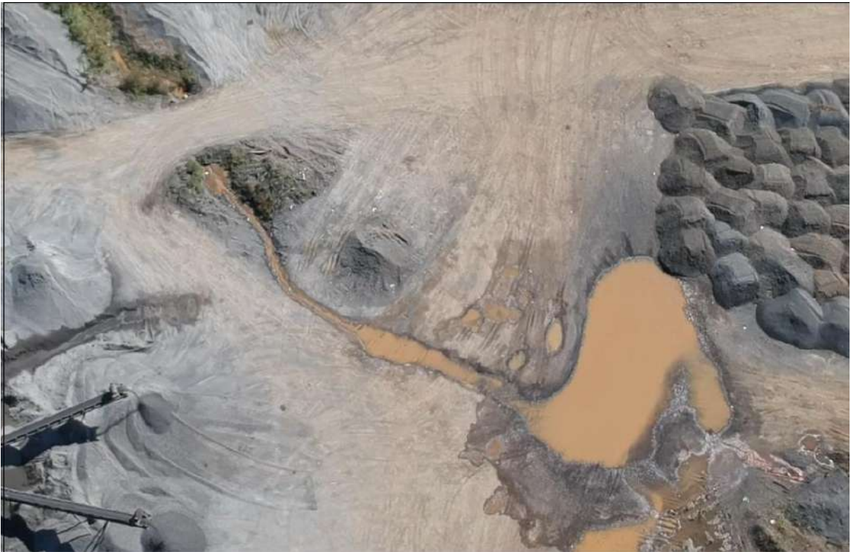
Hình 9. Công thoát nước mưa và hố lắng khu vực chế biến
