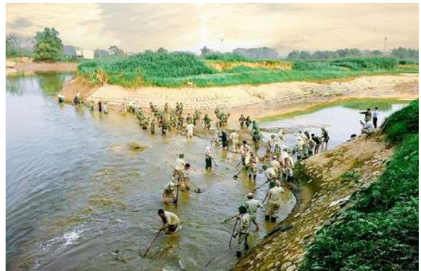
Công nhân Xí nghiệp thủy lợi Móng Cầu - Công ty TNHH MTV thủy lợi Liên Sơn nạo vét, khơi thông dòng chảy, góp phần đảm bảo nhiệm vụ tưới tiêu và bảo vệ môi trường nguồn nước
