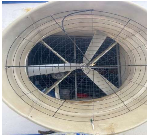
Hình 3.8. Hệ thống phun sương lưới lan giảm mùi quạt hút tại dự án
