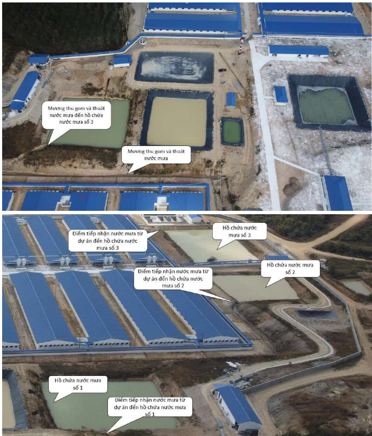
Hình 3.2: Hình ảnh hệ thống thu gom và thoát nước mưa của trang trại *Sơ đồ minh họa
