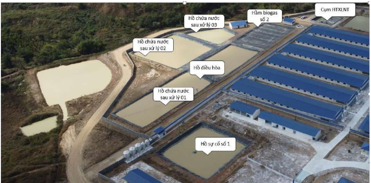
Hình 3.8: Hình ảnh hệ thống xử lý nước thải tập trung của trang trại
