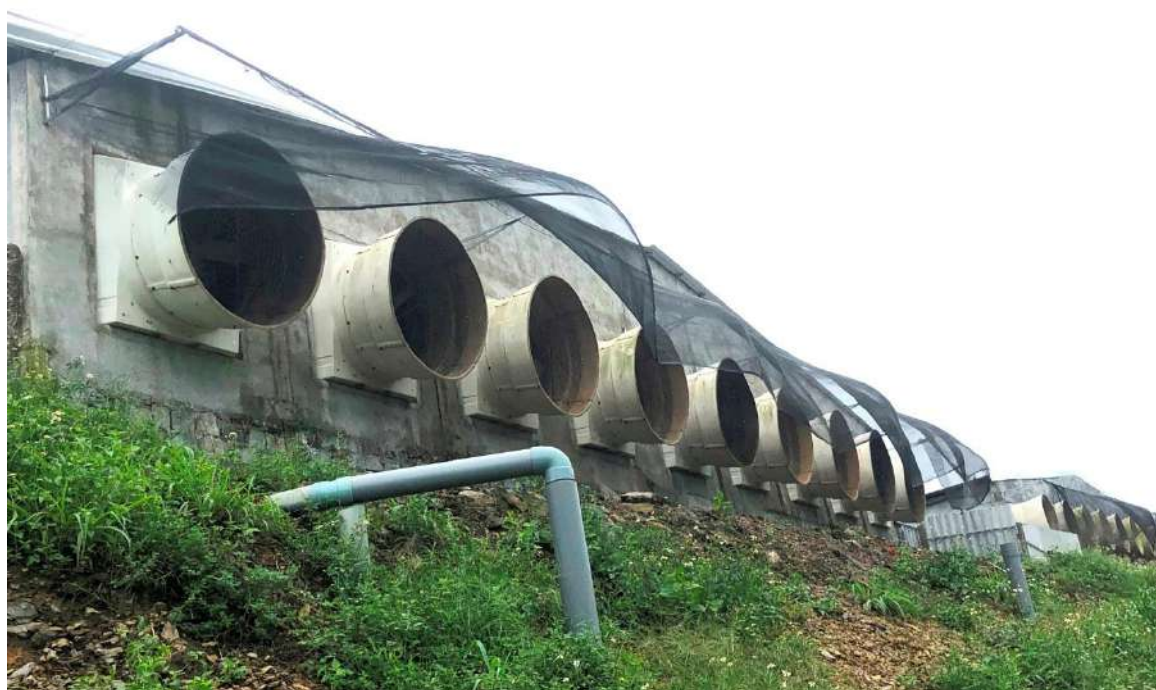
Hình 4.19. Hình ảnh lưới che kết hợp hệ thống phun khử mùi sau quạt hút
