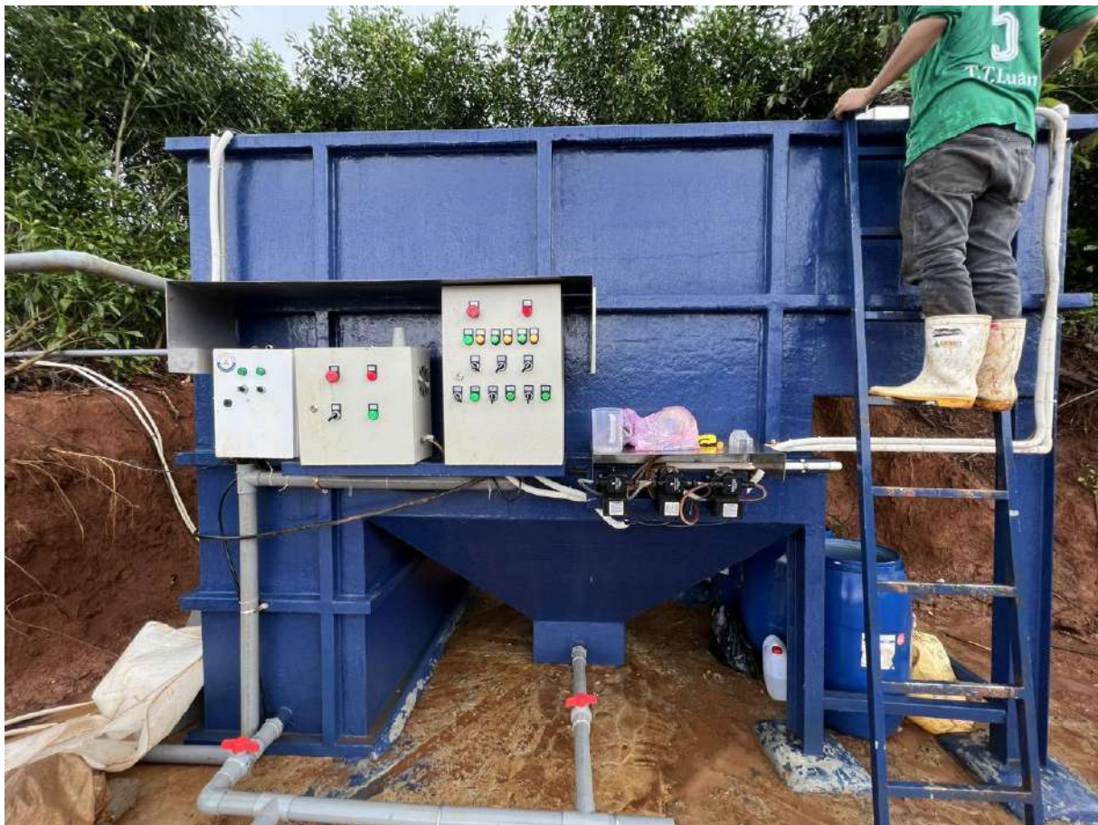
Hình 4.14. Hình ảnh Modul xử lý nước thải – công suất 50m 3 /ngày đêm của Trại Đồng Tiến 1 của Hộ gia đình ông Nguyễn Văn Trí tại xã Đăk Sin, huyện Đăk R’Lấp
