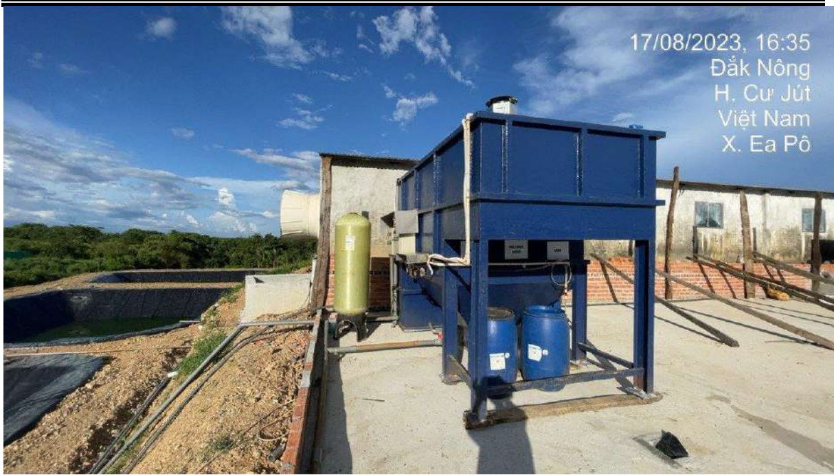
Hình 4.13. Hình ảnh Modul xử lý nước thải – công suất 50m 3 /ngày đêm của Trại chăn nuôi heo thịt Hộ gia đình ông Lương Hữu Tâm tại xã Ea Pô, huyện Cư Jút
