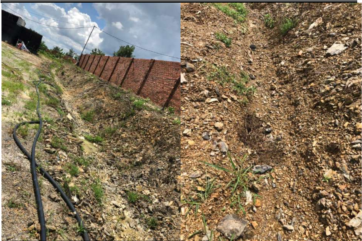
Hình 4.18. Hình ảnh mương đất thoát nước mưa của dự án
