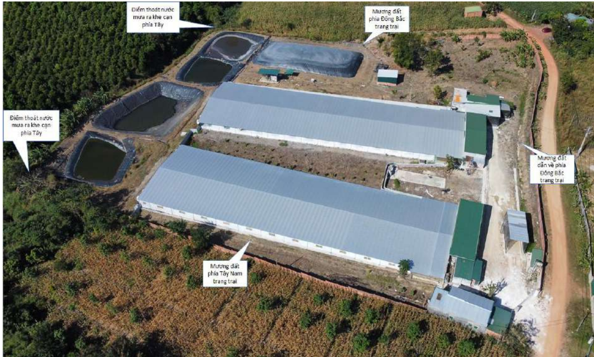
Hình 4.17. Hình ảnh hệ thống thu gom và thoát nước mưa của dự án
