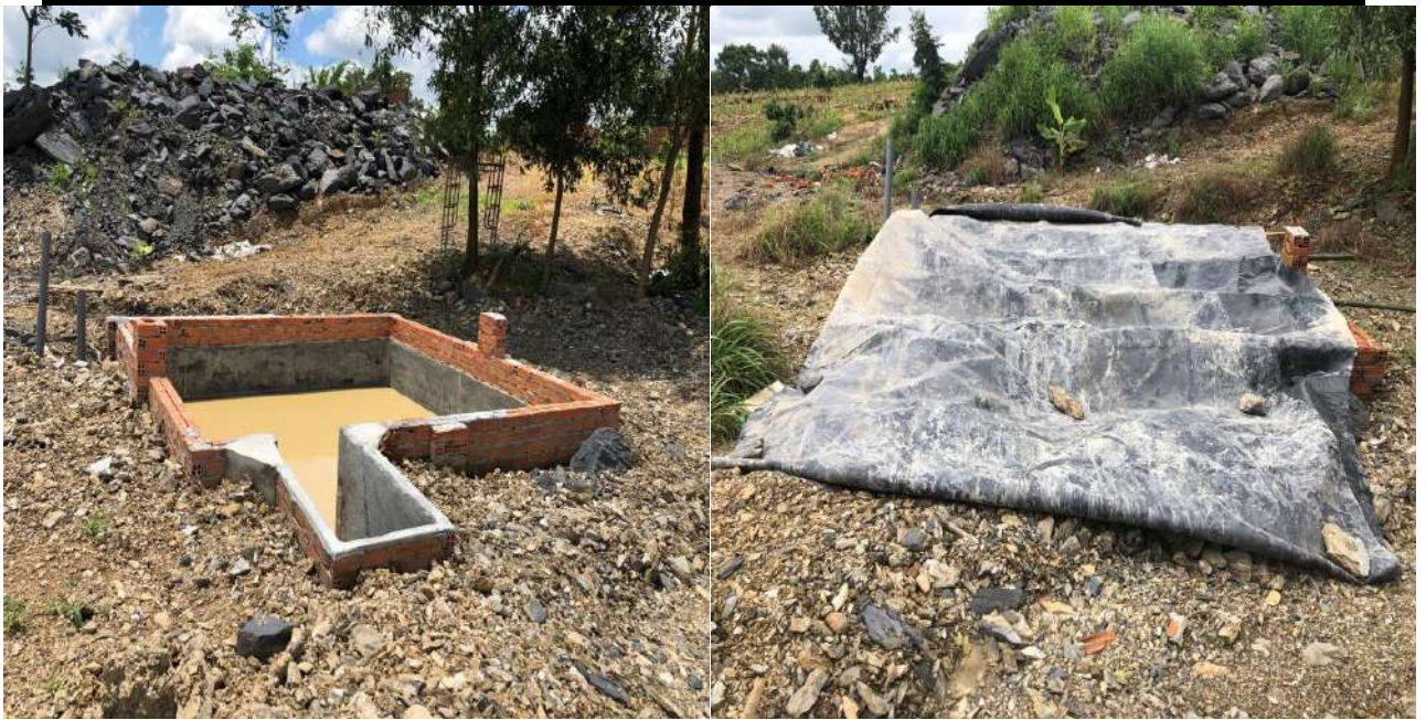
Hình 4.5. Hình hố tách phân
