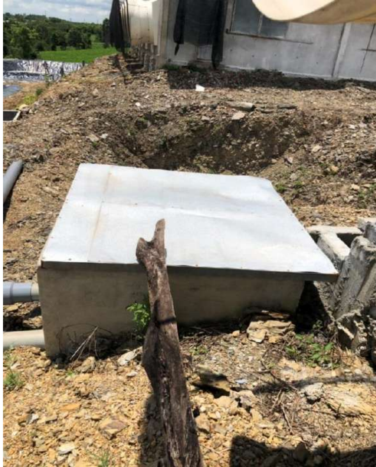
Hình 4.4. Hình hố ga thu gom nước thải
