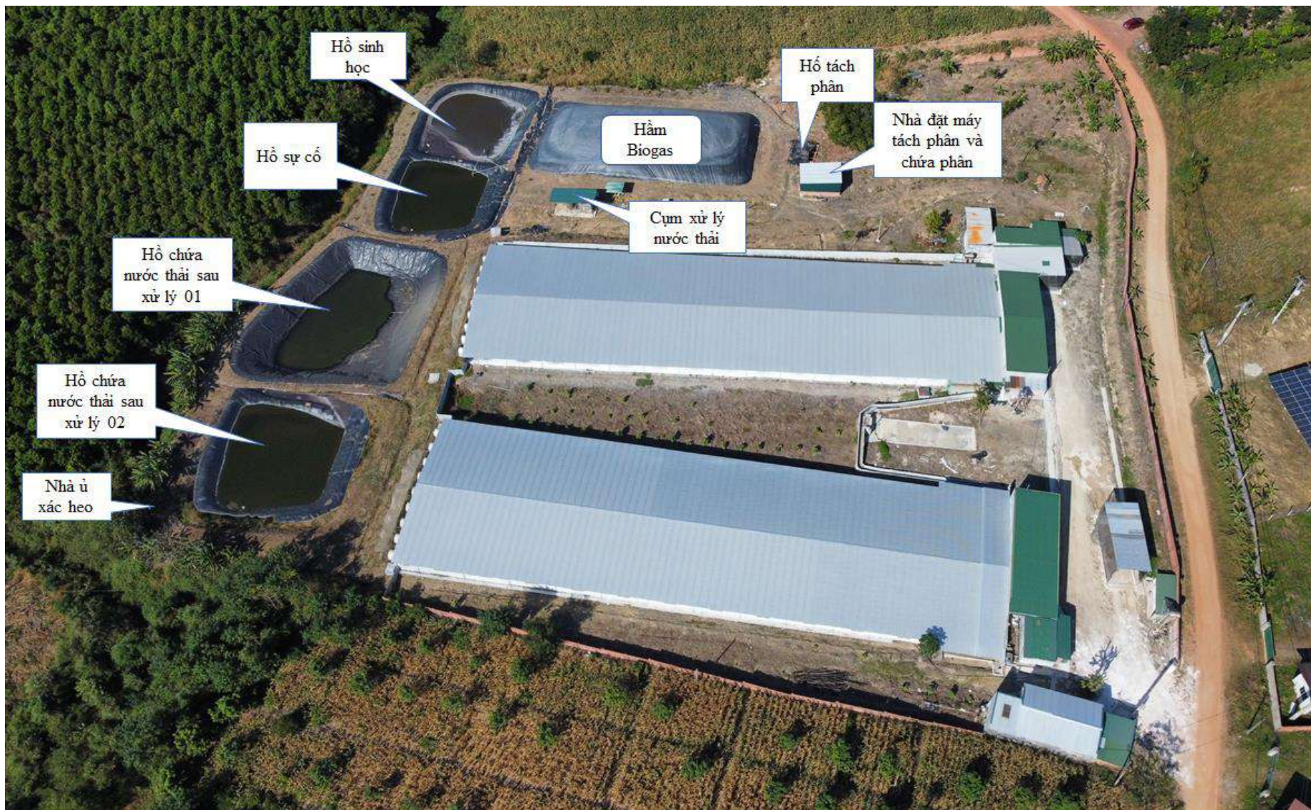
Hình 4.8. Hình ảnh hệ thống xử lý nước thải tập trung của dự án
