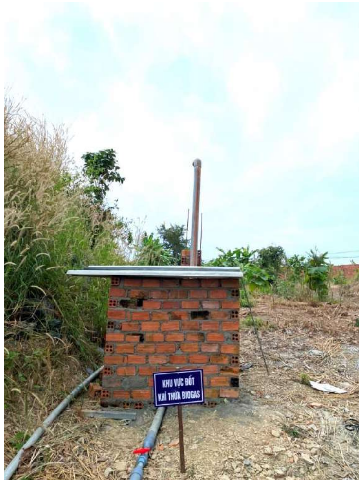
Hình 4.21. Hình khu vực đốt khí gas thừa
