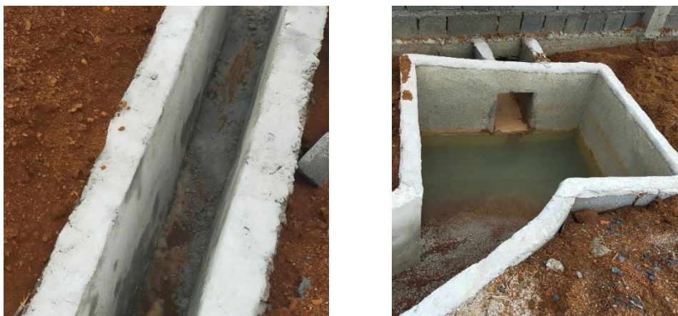
Hình 3. 1 Đường mương thu gom nước mưa
