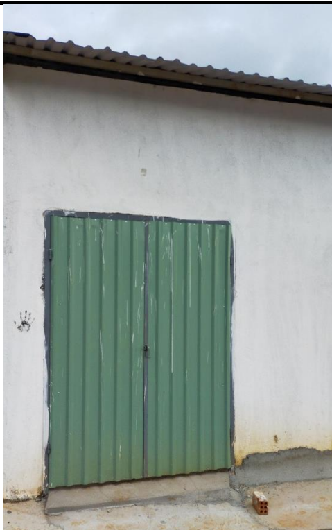
Hình 3. 14 Nhà chứa Chất thải rắn sinh hoạt
