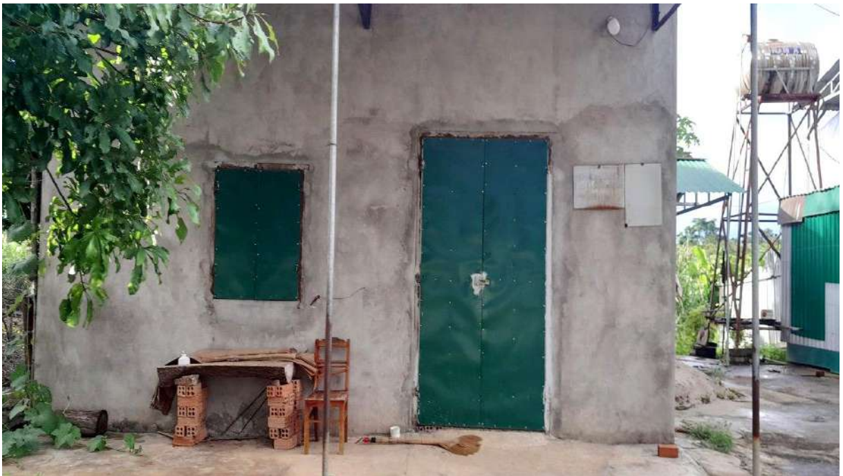
Hình 1.3. Nhà ở công nhân
