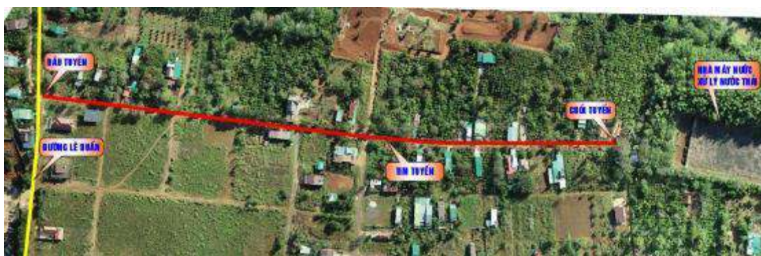
Hình 26: Hướng tuyến đường vào nhà máy xử lý nước thải hiện hữu
