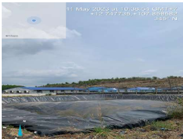
Hầm biogas nhỏ
