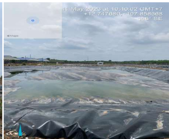
Hầm biogas lớn
