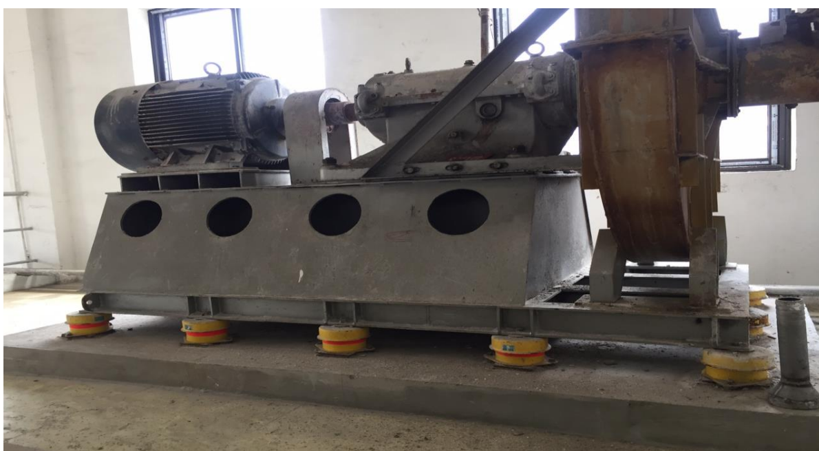
Hình 19. Hình ảnh minh họa giảm rung cho quạt
