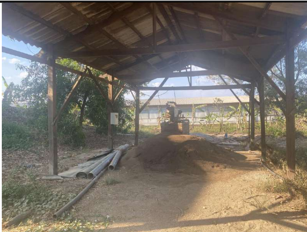
Hình 1.11: Nhà chứa máy ép phân
