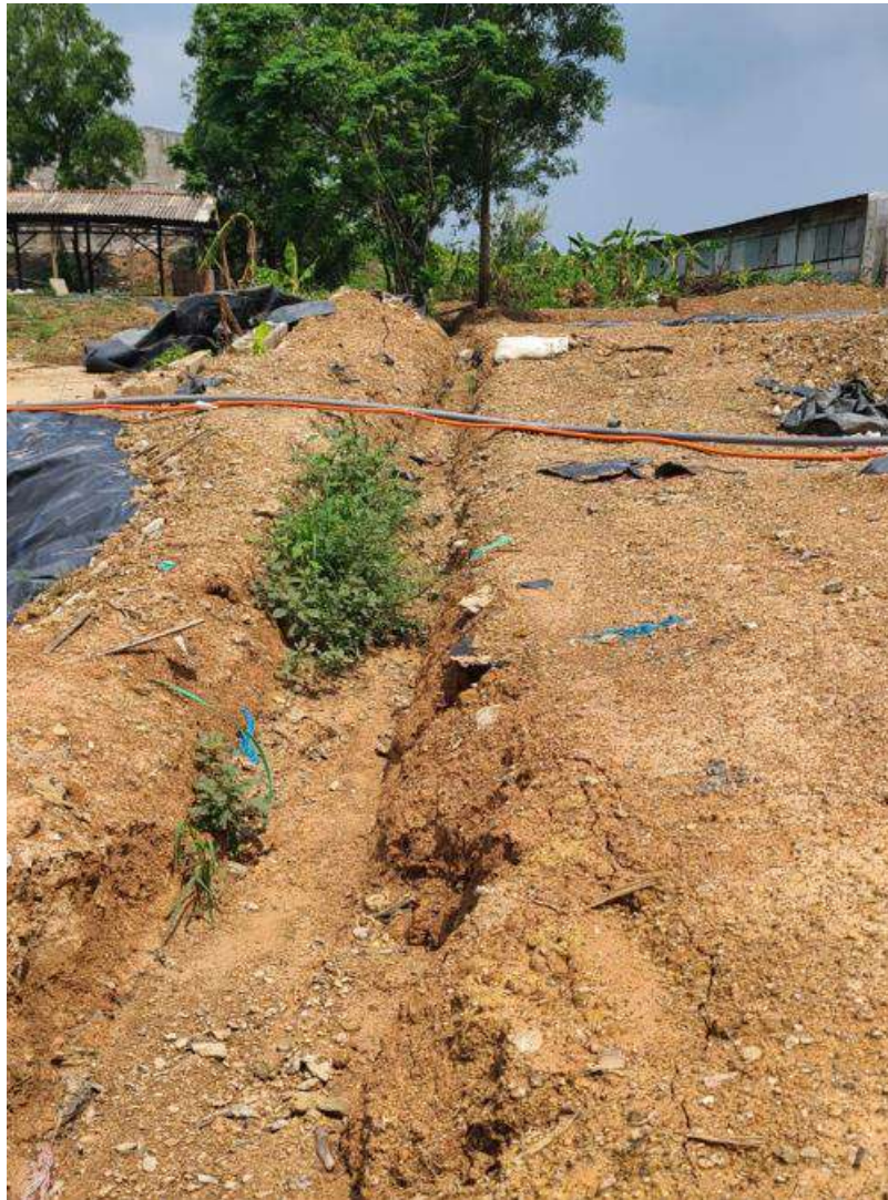
Hình 3.2: Hình ảnh mương đất thoát nước mưa của trang trại
