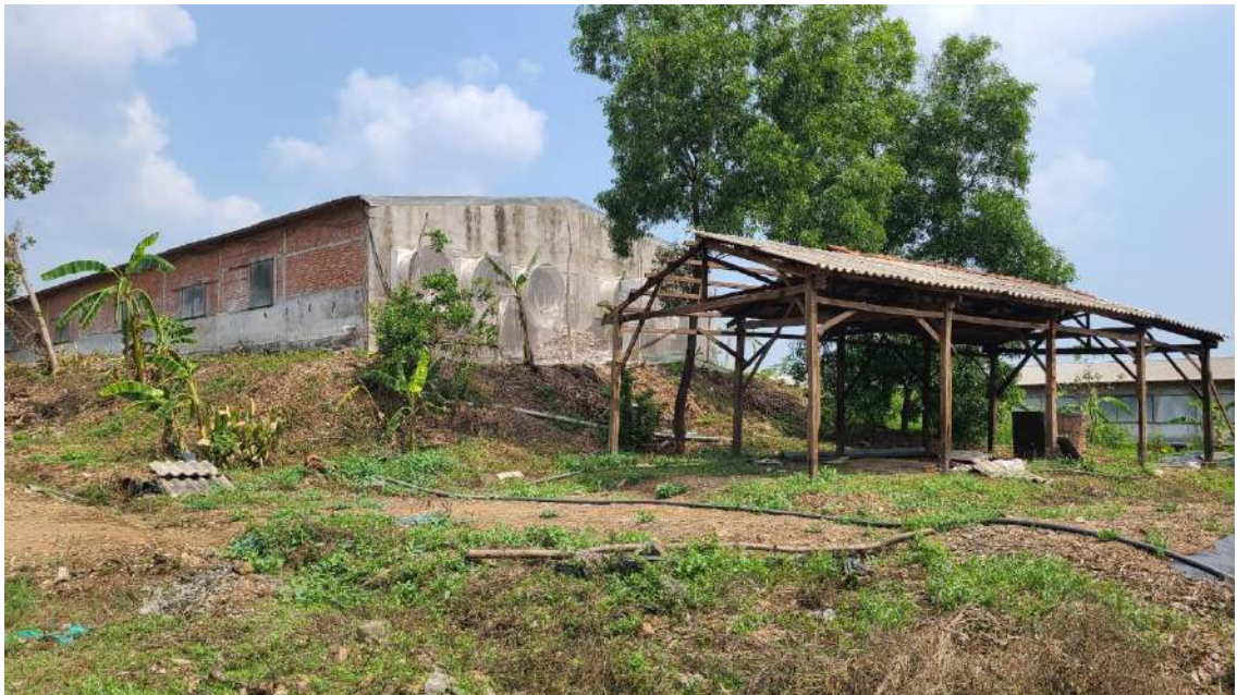
Hình 3.12: Nhà đặt máy ép tách phân của trang trại.
