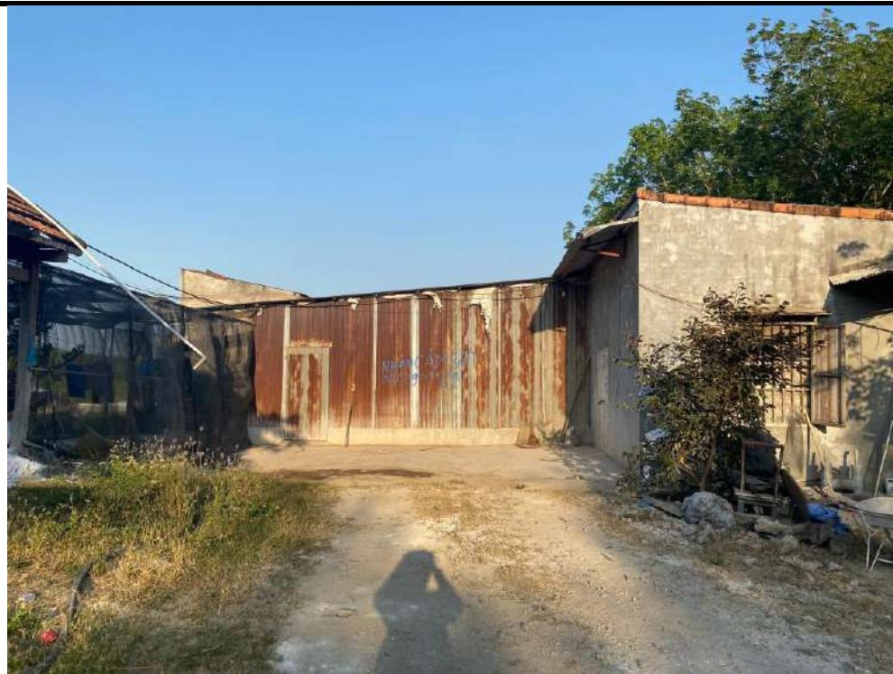
Hình 1.4: Nhà ở công nhân
