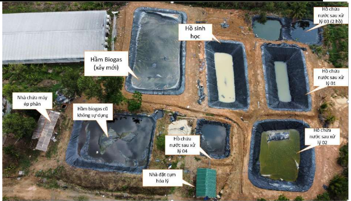
Hình 3.5 : Khu xử lý nước thải thực tế của trang trại
