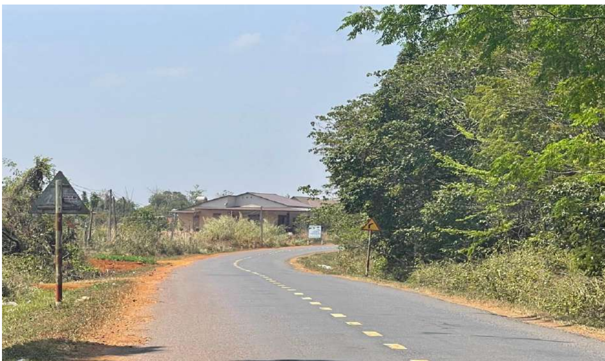
Hình 3.10: Tuyến đường Tuần tra biên giới gần khu vực dự án
