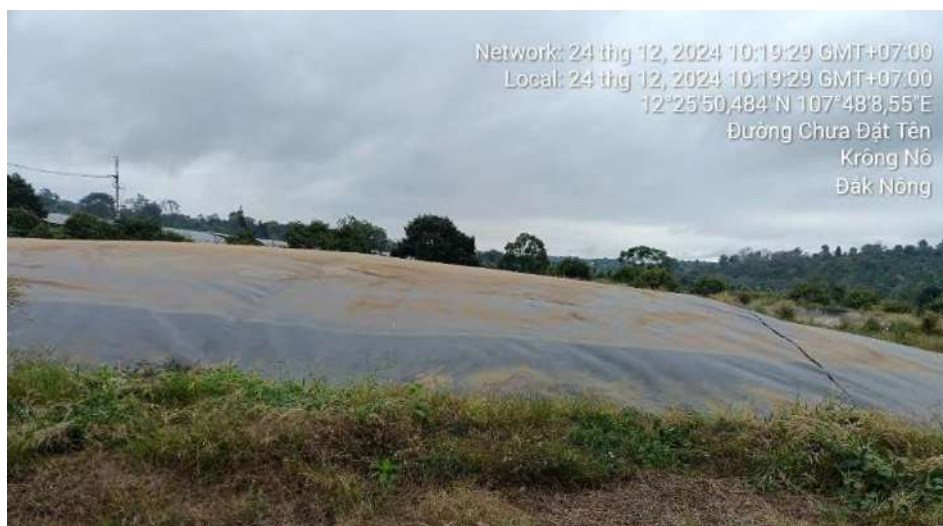
Hình 3.10: Hầm biogas
