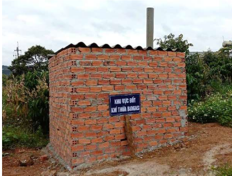
Hình 3.20: Hình khu vực đốt khí gas thừa
