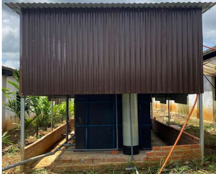
Hình 3.12: Hình ảnh Module XLNT hợp khối
