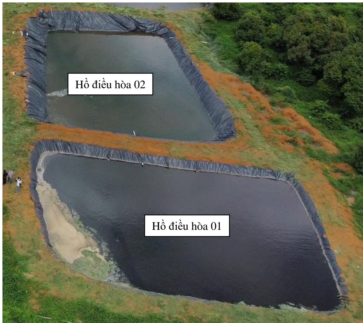
Hình 3.11: Hồ điều hòa 01; 02
