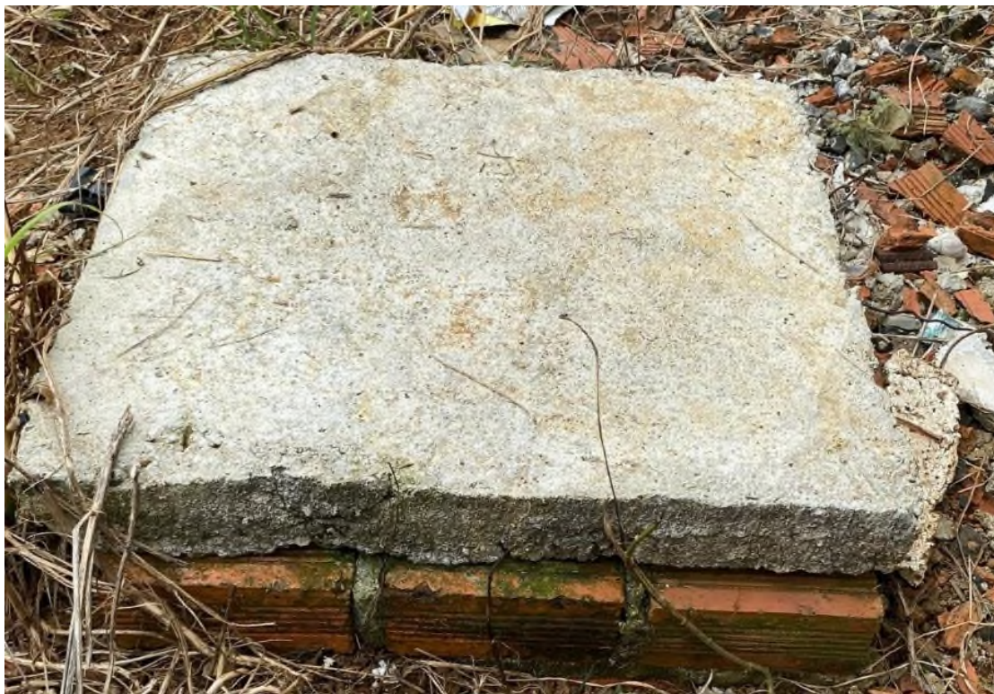
Hình 3.5: Hệ thống ống PVC D168 đi ngầm và hố CT 01 thu gom nước thải dọc hai bên dãy
